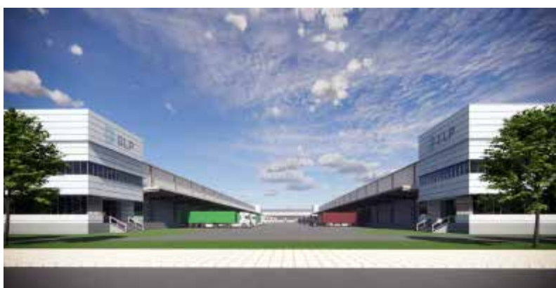
Trung tâm logistics SLP Nam Sơn Hạp Lĩnh, KCN Nam Sơn-Hạp Lĩnh, Bắc Ninh
